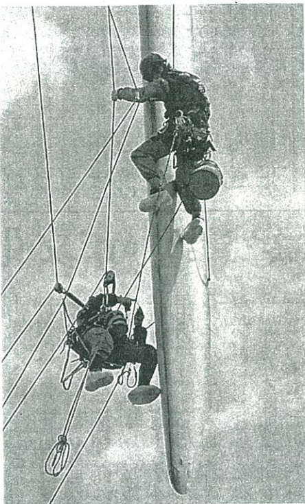
風力発電施設の保守、点検のため高所作業をする技術者(イー・ウィンド提供)
